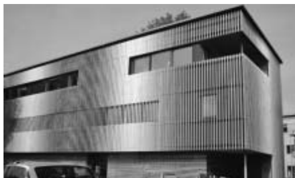
Slika 9. Detalj razmaknutih ravnih letvica na kući u Herbacherovoj ulici i skošeno postavljenih letvica pročelja niskoenergetske kuće
