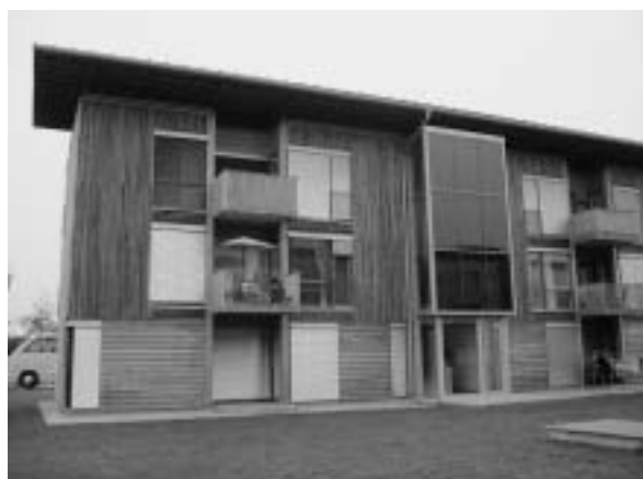
Slika 4. Južna ekspozijska pročelja zgrade sa sunčanim kolektorima
