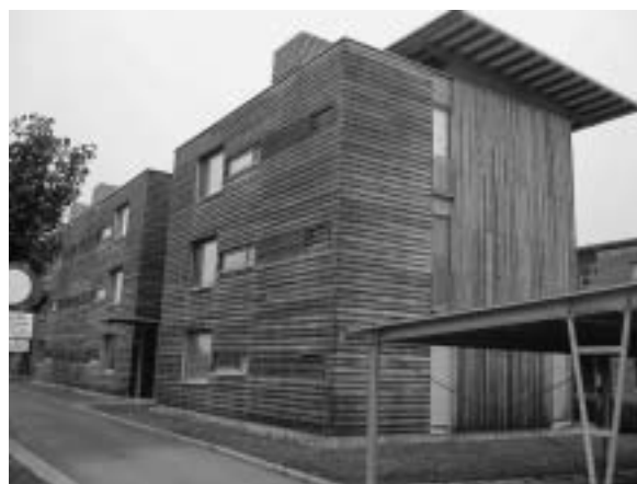
Slika 6. Razlika u dotrajalosti površinskog sloja drva sjevernoga i južnog pročelja stambene zgrade
