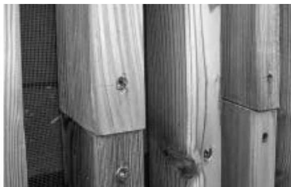
Slika 5. Način pričvršćenja vertikalnih letvica na zgradu
