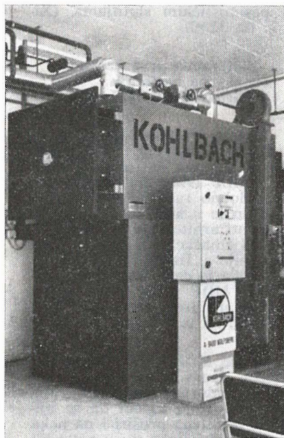
Slika 3. Kotao za loženje drvnim sječkom tvrtke Kohlbach
