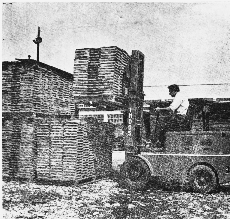
Mehanizacija radova na skladištu piljene građe pridonijela je sniženju transportnih troškova. U tu svrhu svrsishodnu primjenu nalazi viličar »Indos« — na slici gore — i traktor za vuču kolica s piljenom građom — slika dolje.
