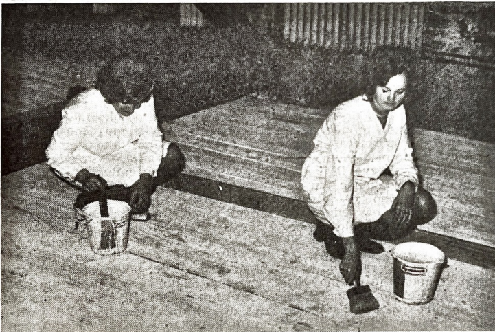
Premazivanje u svrhu provođenja zaštite protiv požara
