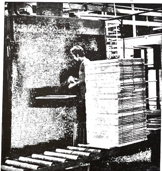
Luženje pištoljem — vide se regal kolica na koja se vješaju okviri, a u pozadini sušionica.
