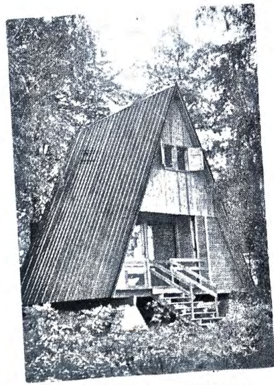
Slika 3. — »DREVINA« — TURANY. Vikendice od prefabriciranih drvenih elemenata.
