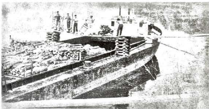
Slika 1. — Ručni utovar prostornog drva u šlep
